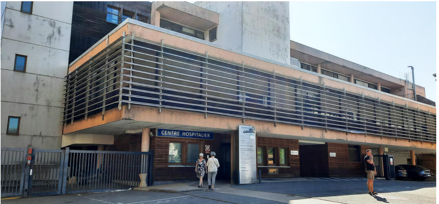
Centre hospitalier à Saint-Marcellin
