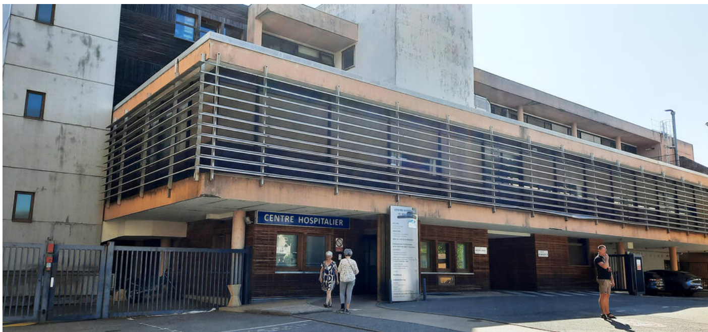
Centre hospitalier à Saint-Marcellin
