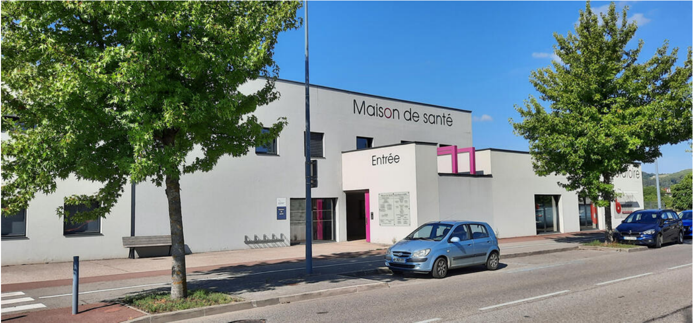
Maison intercommunale de santé à Saint-Marcellin
