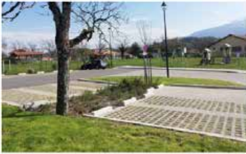
Revêtement perméable, parking de l'école municipale à Chantesse (illustration)
